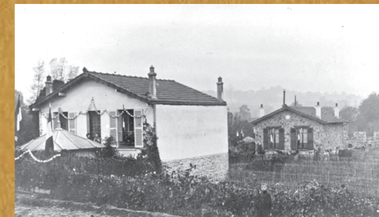
Les maisons ouvrières construites à côté des parcelles des jardins ouvriers.
