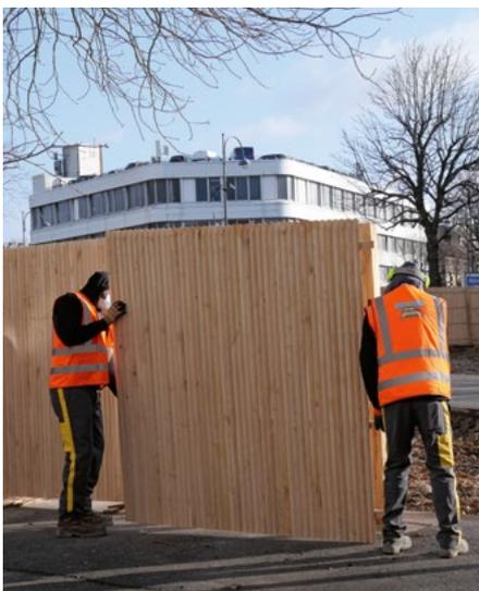
Dans le cadre du diagnostic archéologique préparatoire aux travaux d'extension du centre-ville, la Ville a procédé courant février à la pose de palissades et au décapage de la couche d'enrobé sur l'ex-parking de Gaulle.
