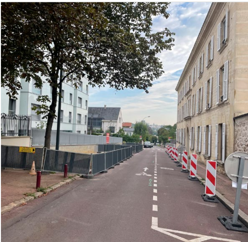
Installation de bandes végétalisées rue du Maréchal-Joffre.
