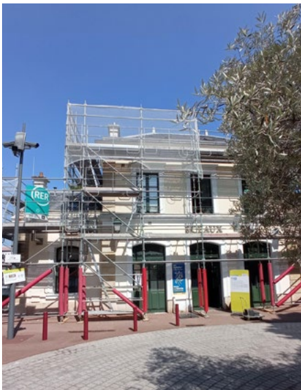
Travaux à la gare RER de Sceaux.
